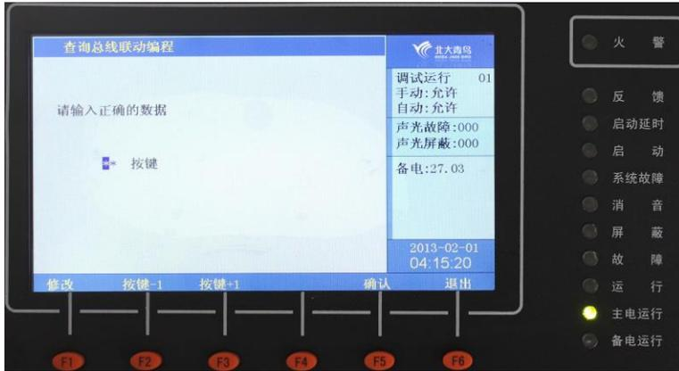
进入控制器查询菜单后，选择数字键【5】进入“查询总线联动关系”选项。
