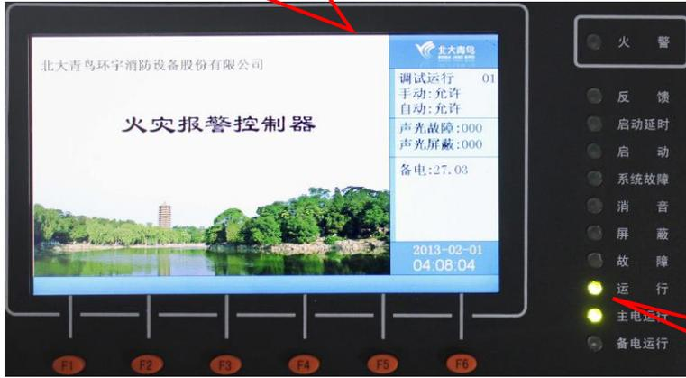
正常工作界面运行灯闪亮，主电工作灯常亮。主页面显示火灾报警控制器标识、时间、日期以及运行状态和手动自动控制方式。
