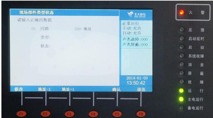
进入控制器测试菜单后，选择数字键【5】进入“现场部件数据查询”选项；
