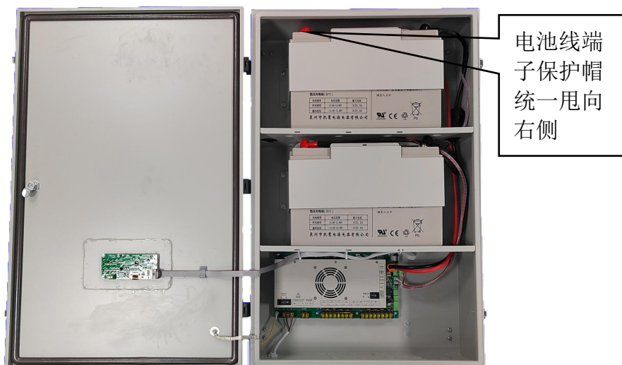
图 5-1 电池安装示意图
