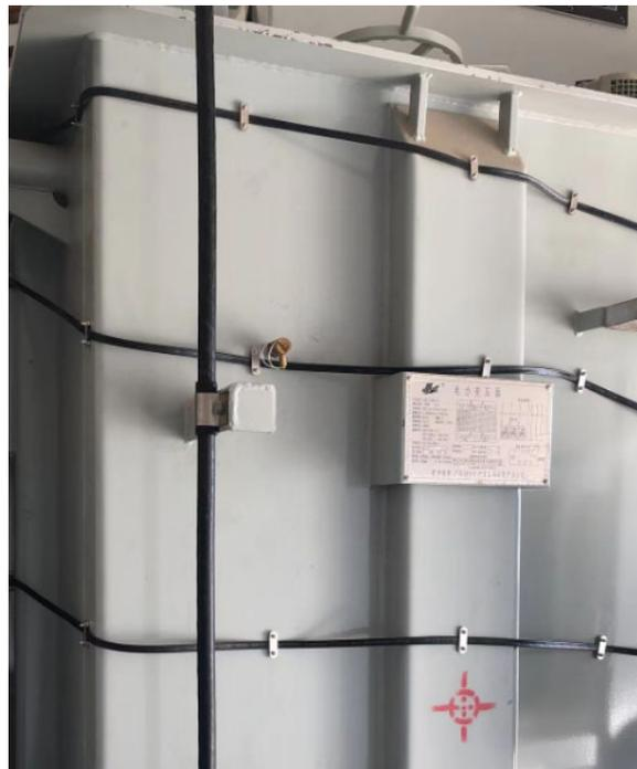
感温电缆变压器本体布置实例图
