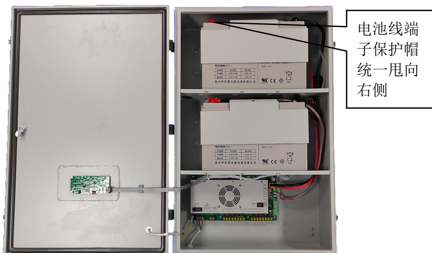
图 5-1 电池安装示意图
